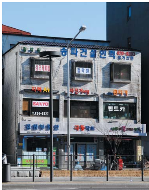
송파대로 구역은 석촌호수 남단부터 가락역 사거리까지 2km를 대상으로 했다. 1층에 설치한 판류형 간판의 프레임은 타공 스틸을 이용해 채널사인을 붙이는 형식으로 제작했다.
