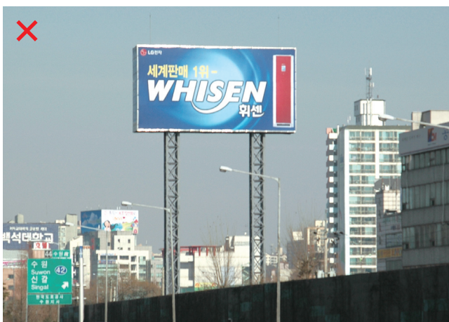
광고면 하단에 관리구역이 없어 시각적 완충지역이 필요해 보인다.
