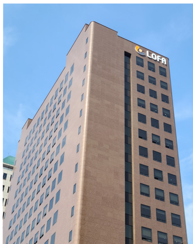
지방재정회관 옥외 현판 설치
